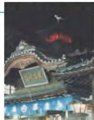
本館の屋上にそびえる振鷺閣
